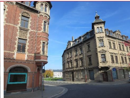
Unsanierter Bestand in der Neustädter Straße
