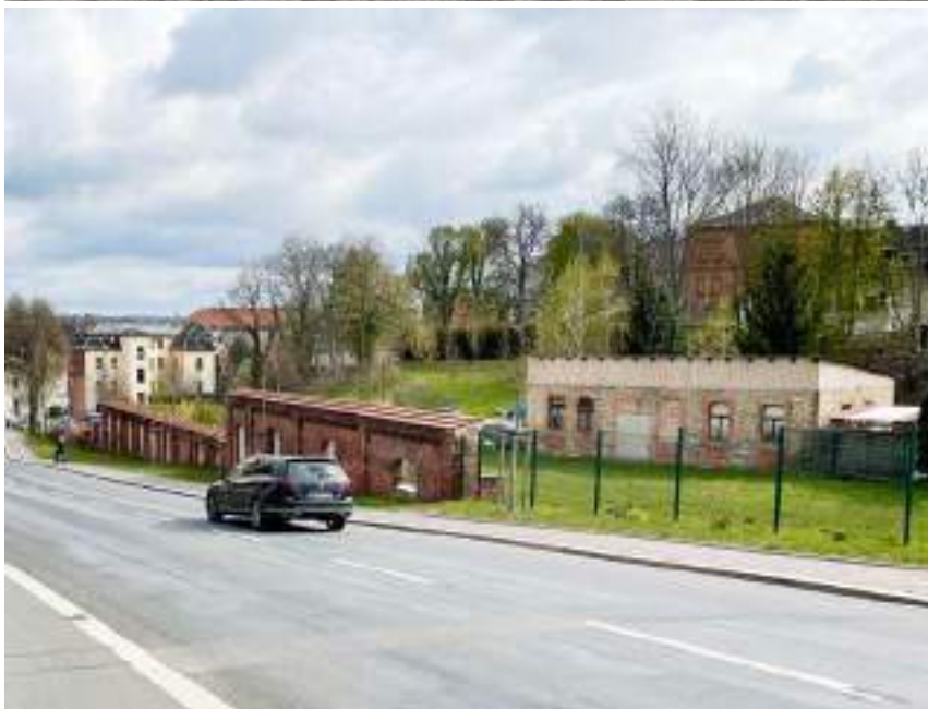
BRACHFLÄCHE STREICHGARNFABRIK PÖßNECK
